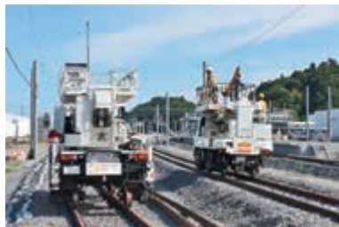
常磐線不通区間の工事状況
