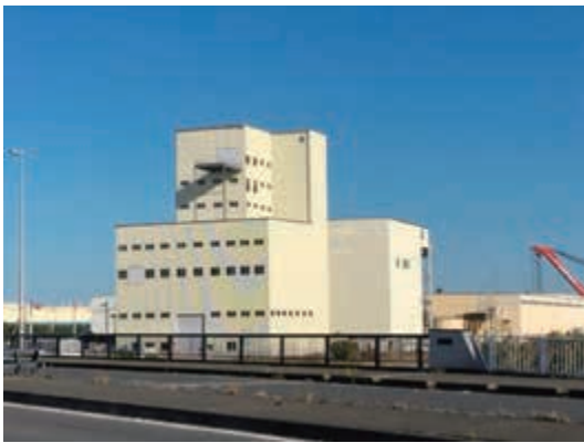
平成30年1月に完成した建屋（久慈町）
